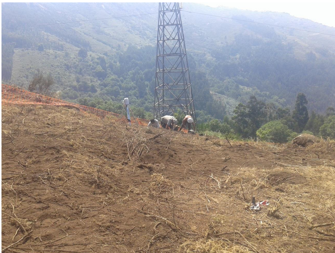
Foto 17. Apoio 51. Fase de trabalho.
