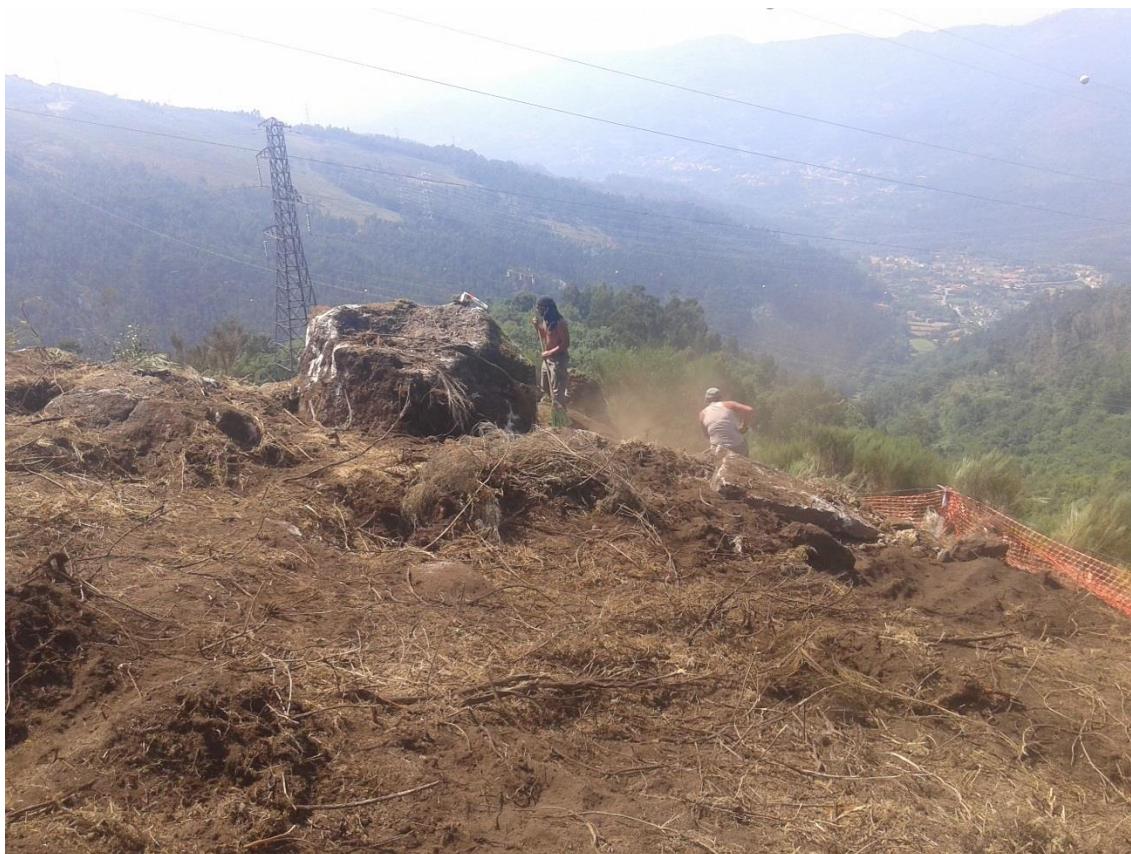
Foto 16. Apoio 51. Fase de trabalho.
